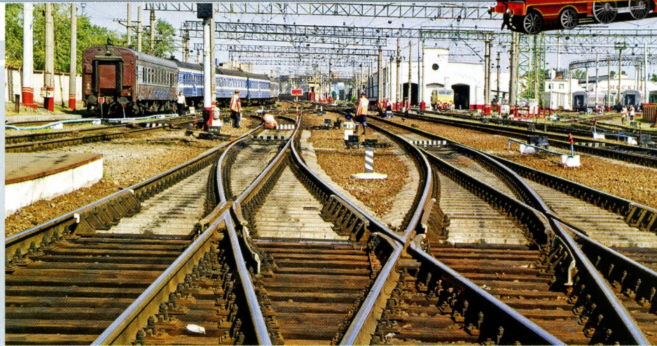
▲ На стрелочных переводах используют особые рельсы – остряки, и контррельсы – и особые, очень длинные, шпалы.
